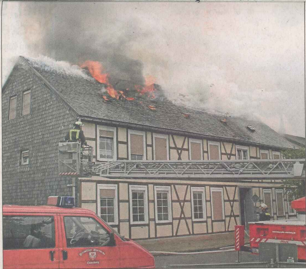
Als die Kameraden gestern Mittag eintrafen und die Drehleiter in Stellung brachten, schlugen ihnen die Flammen aus dem Dachstuhl entgegen. Das Feuer war kurz nach 15 Uhr gelöscht. Fotos (2): J. Gerber
