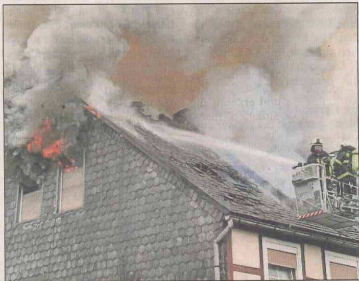
Nicht nur das Dach wurde zerstört. Menschen wurden nicht verletzt, ein Hund und ein Vogel konnten gerettet werden.
